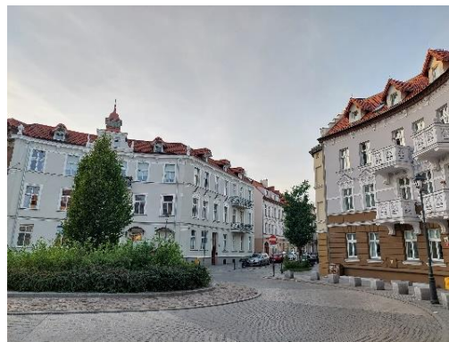
Przebudowana ul. Wajdeloty wraz elewacjami frontowymi niektórych kamienic/fot. BRG
