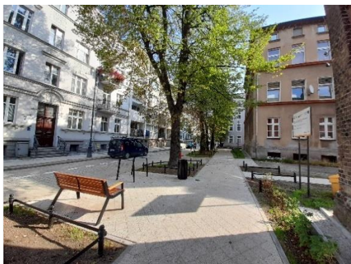
Wyremontowana ul. Przykopowa/fot. BRG
