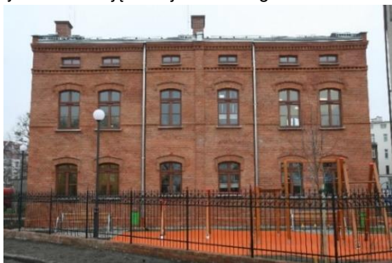
Wyremontowany budynek ul. Dobra 8
