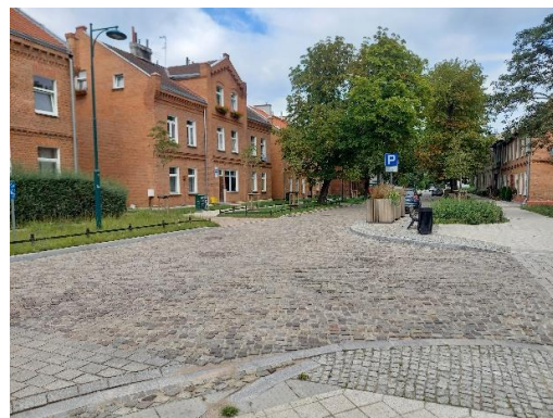
Wyremontowana ul. Wilków Morskich/fot. DRMG
