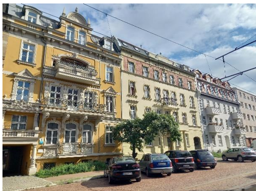
Wyremontowane kamienice przy ul. Rybołowców/fot. BRG
