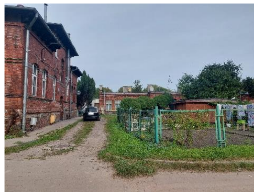
Zabudowa po dawnej kolonii robotniczej przy ul. Reduta Dzik
