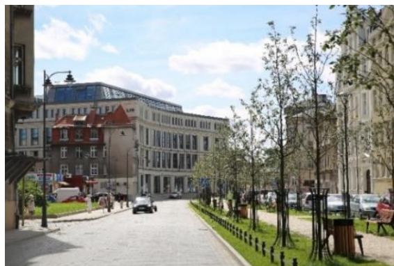
Przebudowana ulica Łąkowa
