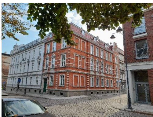
Wyremontowane kamienice przy ul. Toruńskiej/fot. UMG
