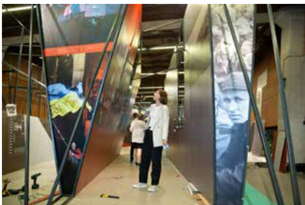
Montaż ekspozycji rozpisano na trzy tygodnie, prace postępują Fot. Katarzyna Granacka | Archiwum ECS
