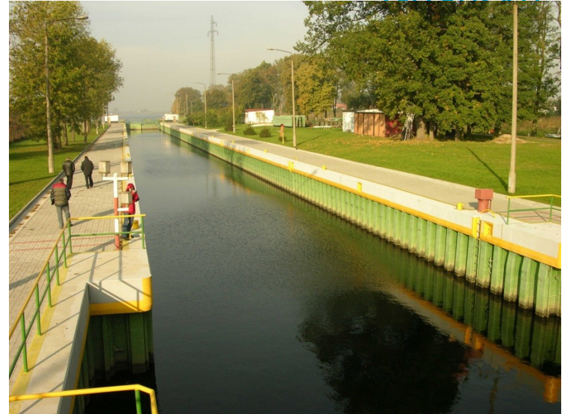
Widok na wrota dolne i maszynownię śluzy
